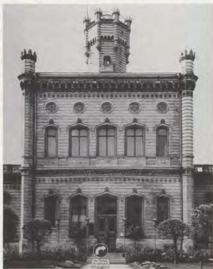
Abb. 16 – Langenargen, Mittelteil des Schlosses Montfort von Norden. Foto von 1972.
