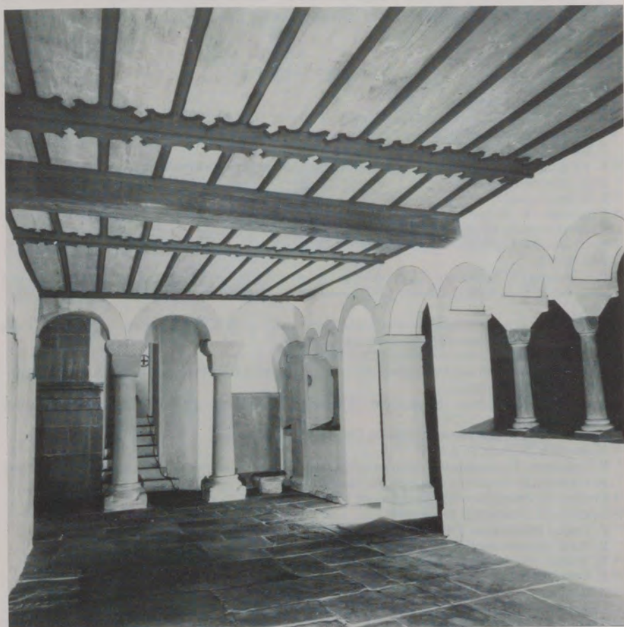
Abb. 4 Vorraum zum Kapitelsaal mit gotischer Bretterdecke.
