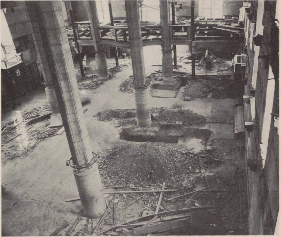
Abb. 3: Johanneskirche Künzelsau. Kirchenschiff von NO bei Beginn der Arbeiten zur Renovierung
