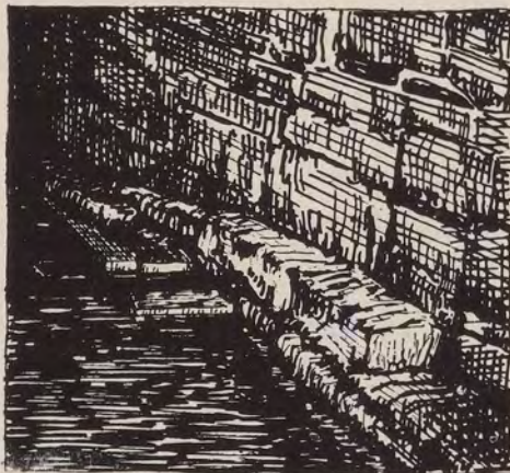
Abb. 8: Arbeit „ungelernter“ und „gelernter“ Maurer im Bereich des fünfeckigen Beckens
