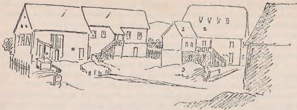
1. Mein altes. Haus. 2. Die Großes Haus. 3. Das Löffelhaus.
