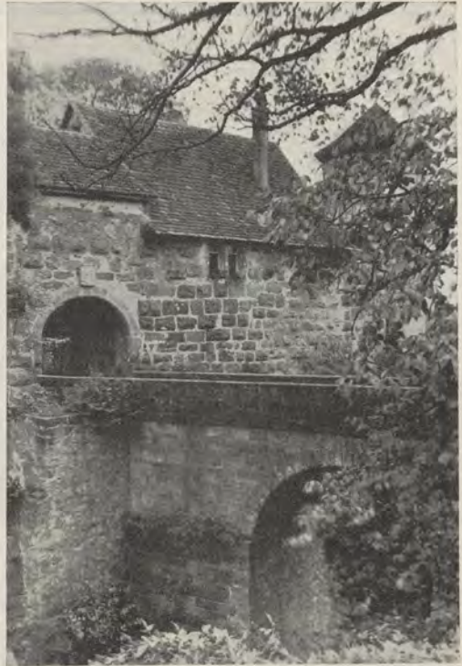
Burg Maienfels (Brücke und Eingang).
