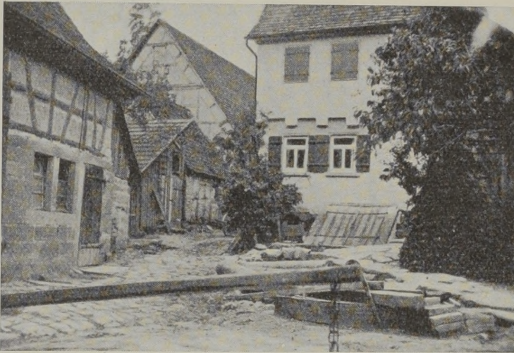
Weingärtnerhof in Michelbach a. W. (Kreis Sörringen). Der Kellervorbau am Wohnhaus, das unterkellert ist, ist hier schon abgebrochen. (Aufnahme Georg Brener.)
