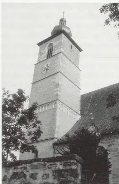
Abb. 13a Ev. Stadtkirche Crailsheim (Foto: K. Hammer)
