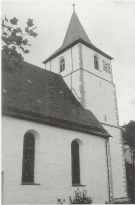
Abb. 9a Ev. Kirche Wachbach (Foto: K. Hammer)
