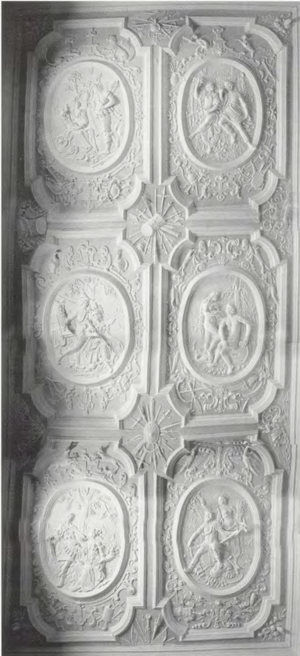
Abb. 7 Johann Kuhn: Neue Tafelstube, Stuckdecke, provisorische, nicht maßstabgerechte Montage
