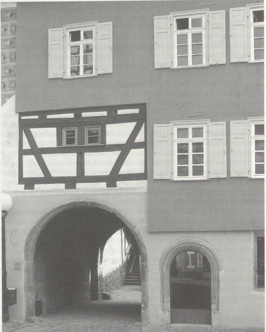
Abb. 5 Hofeinfahrt. Oberhalb sind die drei historischen Wandauffassungen erkennbar, die das Fachwerk des Mühlenschen Baus (1597/98), die darauf folgende Phase der Diamantierungsmalerei und die Putzfassung der Barockzeit zeigen. Rechts davon liegt der ursprüngliche Zugang zur Eingangshalle im Erdgeschoß (LDA, B. H.).
