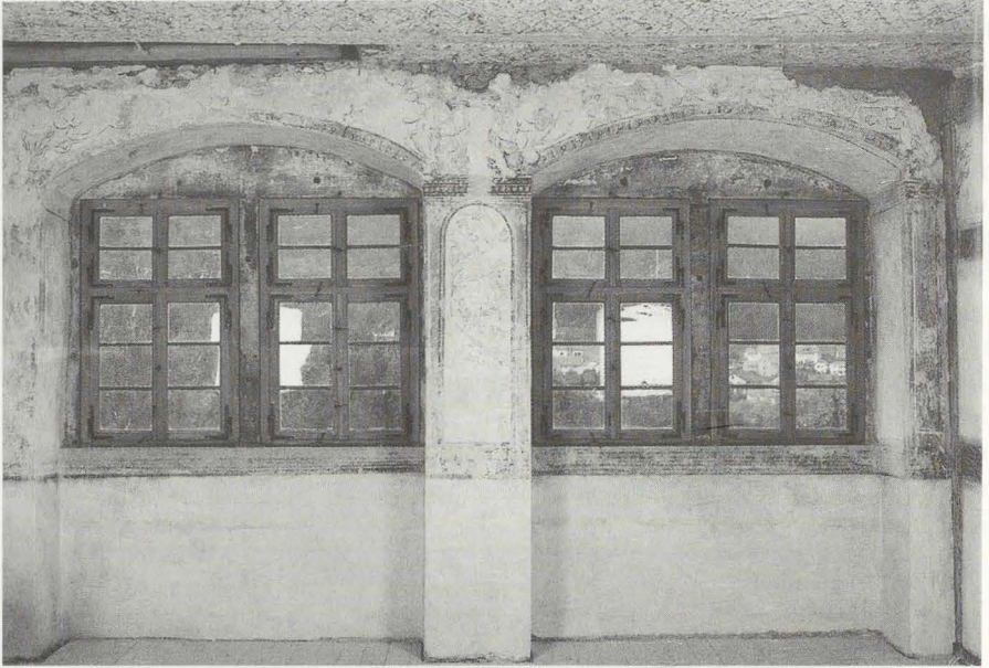
Abb. 7 Mit Dekorationen des 16. Jahrhundert ausgemalte Fensternischen im größeren Repräsentationsraum des 2. Obergeschosses (LDA, B. H.).
