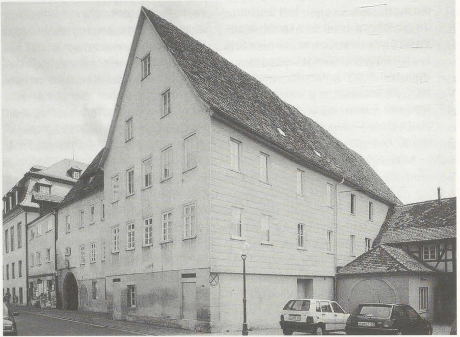
Abb. 9 Straßenfassade des „Schwarzen Hofes“ vor der Instandsetzung, Aufnahme 1997 (LDA, A. W.).
