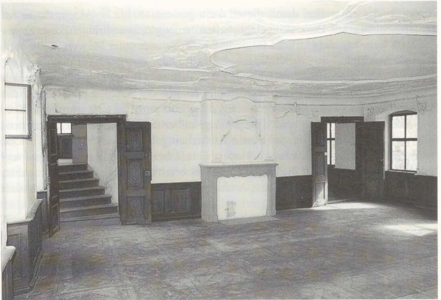
Abb. 3 Stuckierter Saal im sogenannten „Neuen Archiv“ auf der Wertheimer Burg (Aufnahme: Foto Wehnert, Wertheim).
