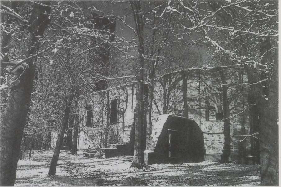
Abb. 7 Außenansicht der Kirchenruine auf dem Einkorn von Südosten (Zustand 1998), Foto: Verfasser.
