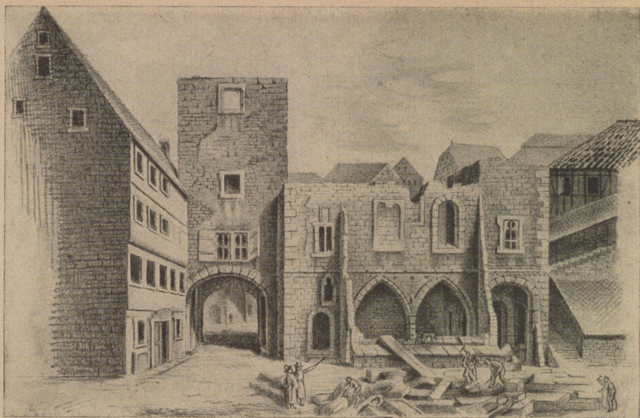
Abb. 29. Stadtseite von Stätt-Tor und Schöntaler Kapelle während des Abbruchs 1808 (nach Zeichnung von Major von Gaupp, kopiert von F. Reik 1874; Keckenburgmuseum).
