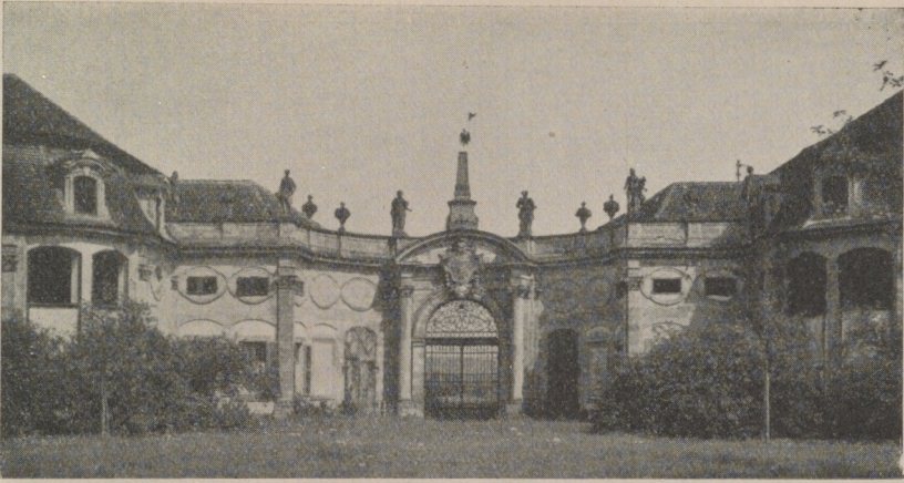
Abb. 6. Balthasar Neumann, Orangerie in Seehof bei Bamberg.
