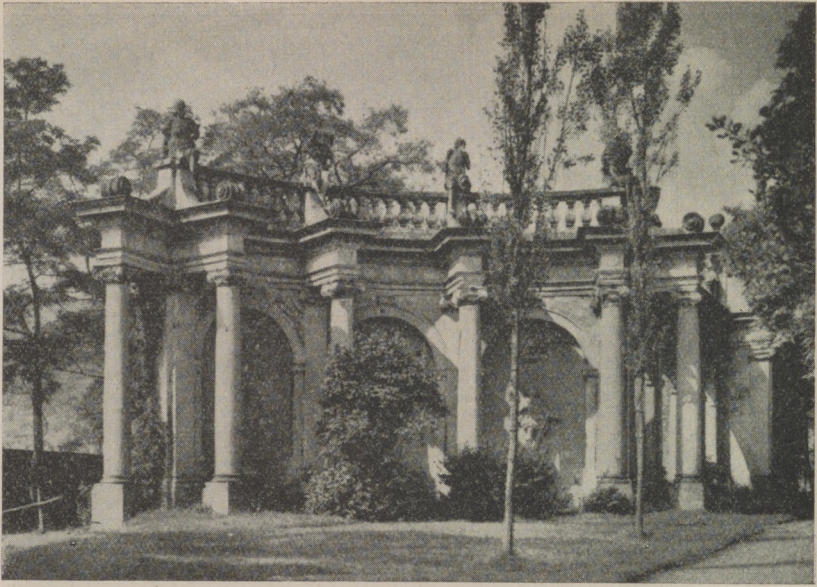
Abb. 15. Orangerie in Weikersheim, westliche Kolonnade.
