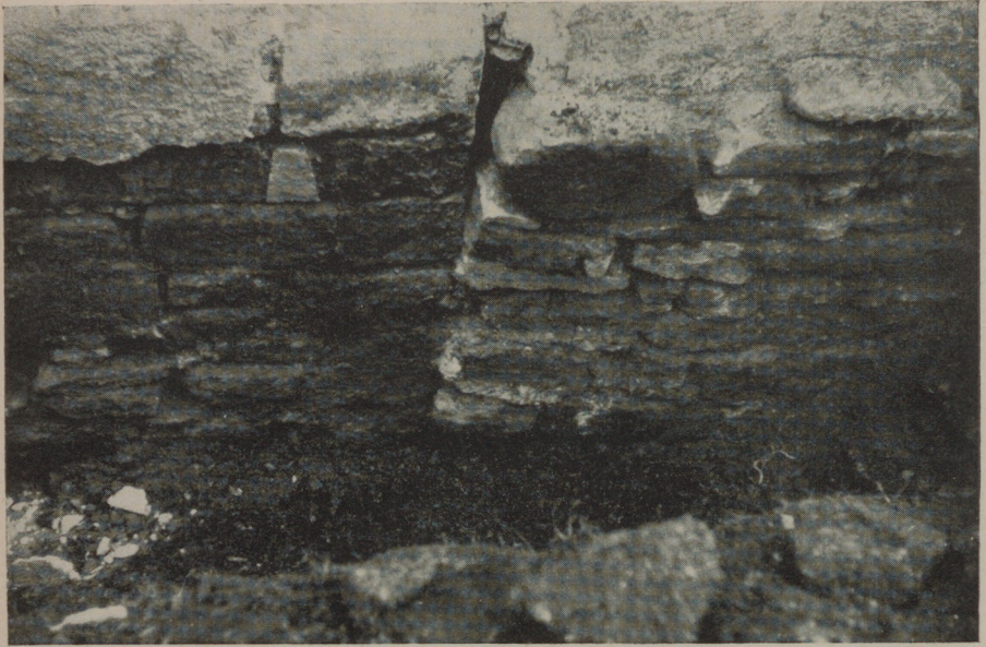
Abb. 7. Anstoß der spätromanischen Kapellenmauer (links) an die karolingische Mauer.
