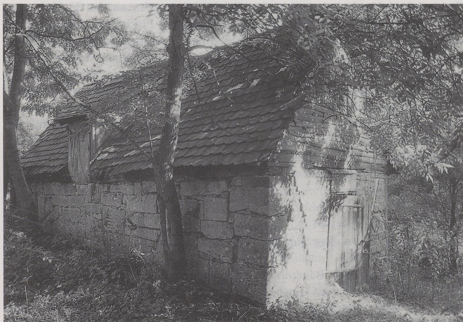
Abb. 12 Das Brechhaus in Amlishagen vor der Translozierung in das Hohenloher Freilandmuseum (Bildarchiv Hohenloher Freilandmuseum, Fotograf: Heinrich Mehl).
