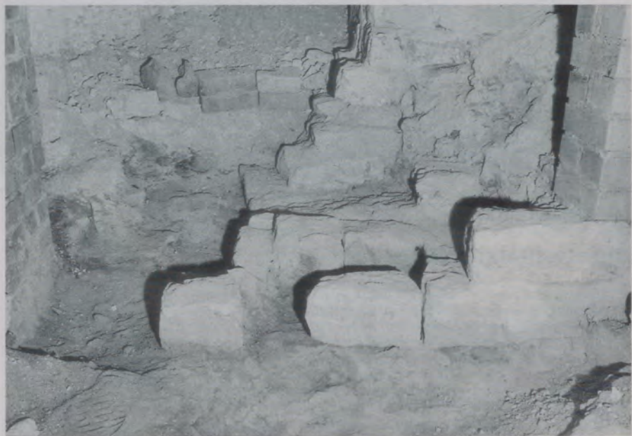
Abb. 15 Kreuzgang. Blick in den nördlichen Zugang zur Kirche. Im Vordergrund Reste eines Stufenunterbaus, am oberen Bildrand die auf der Innenseite verputzte Südwand des Durchgangs. Links eine barocke, rechts eine moderne Backsteinmauer.
