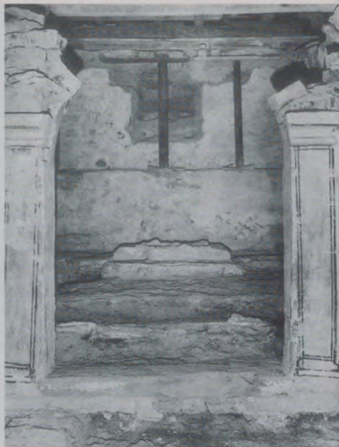
Abb. 9 Krypta. Blick durch den Triumphbogen in den Kryptenchor mit Resten der ehemaligen Altarstelle.
