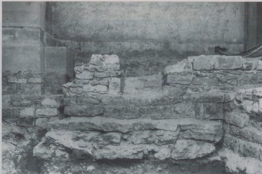
Abb. 12 Mittelschiff. Das Spanfundament der Mittelschiffarkaden, rechts schließt sich die Rückseite der Kriptenwestwand an. Aufgesetzt ist das Mauerwerk einer Chorabschränkung, die deutlich eine Aussparung für eine ehemalige Pfeilervorlage freiläßt.
