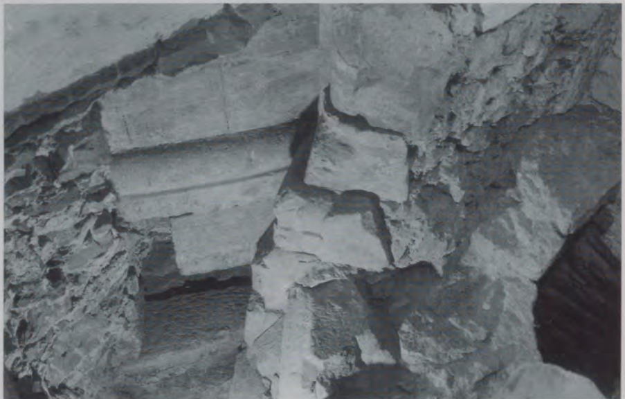
Abb. 11 Nordostturm. Rechts das Fundament der nördlichen Nebenapsis, daneben die Reste des eingestellten Dienstes und links anschließend der Außensockel der ehemaligen Hauptapsis.
