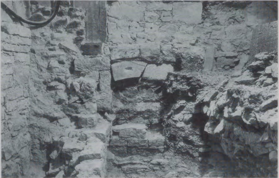
Abb. 10 Nordostturm. Blick auf die nachträglich vermauerte Westwand, dunkel zeichnet sich das Gewände des ehemaligen Durchgangs ab. Im Vordergrund links die romanische Kirchennordwand, rechts die Abmauerung des Kryptenzugangs.
