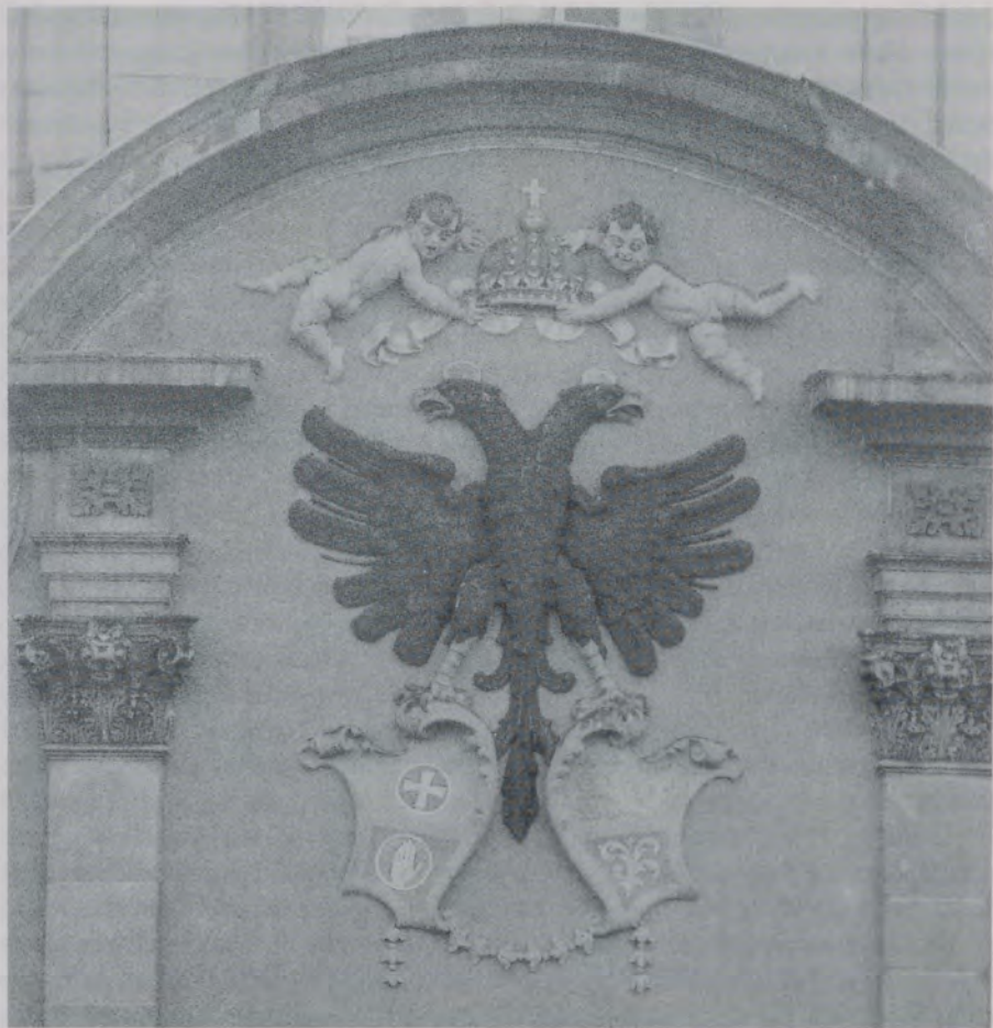
Abb. 6a Bauaufnahme der reichsstädtischen Hoheitszeichen am Giebel des Rathauses zu Schwäbisch Hall (Photo, Kern-Atelier, Schwäb. Hall)
