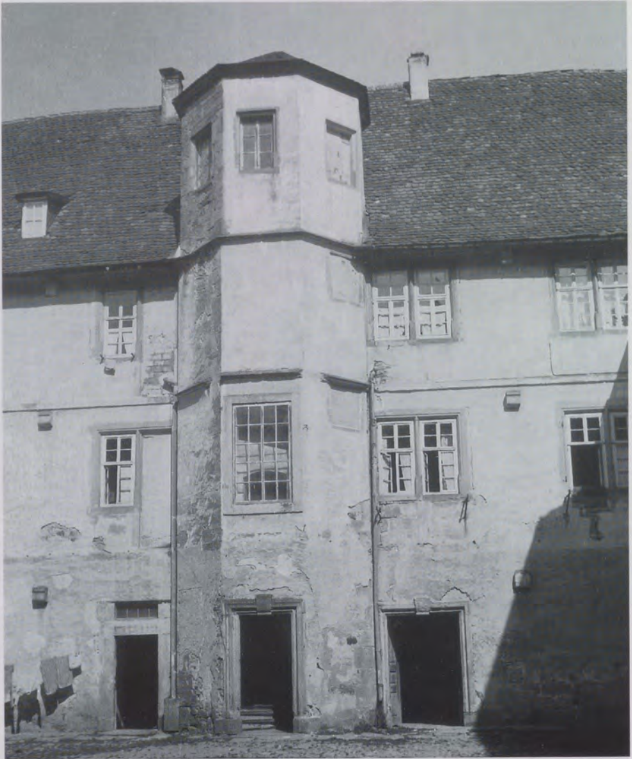
Abb. 18 Schloß Pfedelbach, Nordbau, Hofseite mit Treppenturm. Die in den Anfängen steckengebliebene Barockisierung hat im Erdgeschoß neue Türgewände eingesetzt und im Obergeschoß dem Treppenturm ein ohne Rücksicht auf die Treppe dahinter auf Geschoßhöhe sitzendes Fenster eingebaut. Die der ansteigenden Wendeltreppe folgenden Fenster wurden vermauert. Die Konsolsteine sollten die Schwellen für den vorzulegenden Fachwerkgang tragen. Links neben dem Turm wurde ein Fenster zur Türe vergrößert. Das Stockgesims über dem Erdgeschoß wurde abgespitzt. Aufn. W.-G. Fleck 1962
