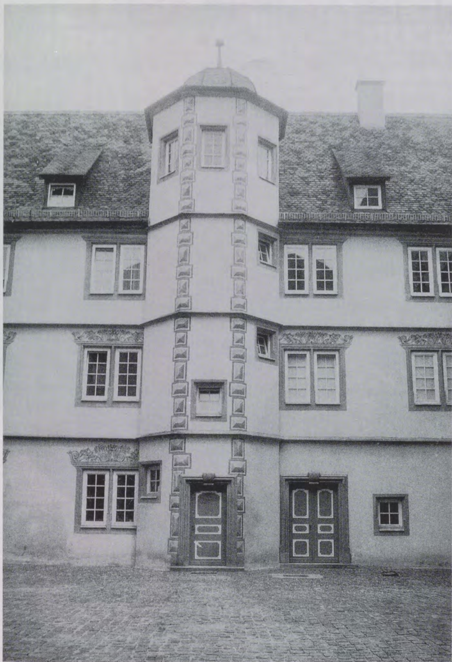
Abb. 38 Schloß Pfedelbach. Nordbau, Hofseite nach der Erneuerung. Aufn. W.-G. Fleck 1979
