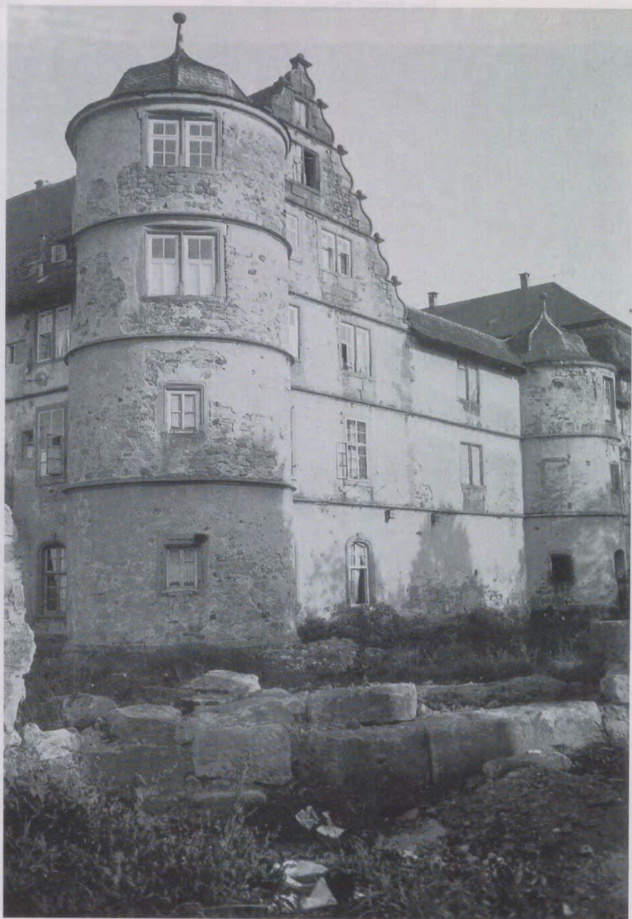
Abb. 16 Schloß Pfedelbach, Nordwestturm, Nordflügel und Westgalerie mit Mittel- turm. Im Erdgeschoß und 1. Stock sind einige barocke Fenster zu sehen, sonst ist der Erstzustand gut erhalten. Aufn. W.-G. Fleck 1962
