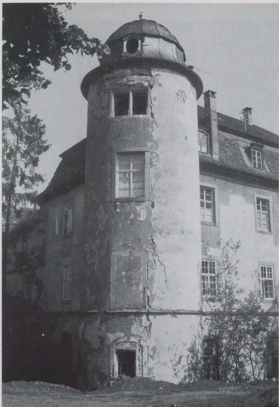
Abb. 17 Schloß Pfedelbach, Südflügel und Südwestturm. Im obersten Turmgeschoß blieb das Renaissancefenster erhalten. Es sollte so durch einen Stuckrahmen kaschiert werden, wie das mit dem ebenfalls alten Erdgeschoßfenster geschah. Durch das Einbrechen der großen Fenster entstanden starke Risse. Aufn. W.-G. Fleck 1962
