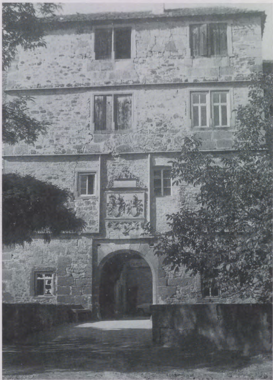
Abb. 14 Schloß Pfedelbach, Torbau. Um das Tor die Vertiefung für die Schlagbrücke; oben rechts und links die Rollen für die Aufzugseile. Über dem Tor das Allianzwappen Hohenlohe-Tübingen. Links vom Tor sind die Eckquader des zunächst schmaler geplanten Torturms zu sehen. Aufn. W.-G. Fleck 1962
