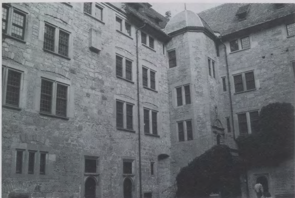
Abb. 36 Hofansicht des Saalbaus mit nord-westlicher »Kleiner Schnecke«. (Aufnahme der Verfasserin)
