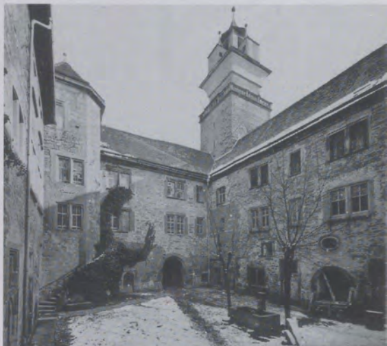
Abb. 28 Hofansicht nach Nord-Osten, 1905. (ABV: N21 2, N4 37)
