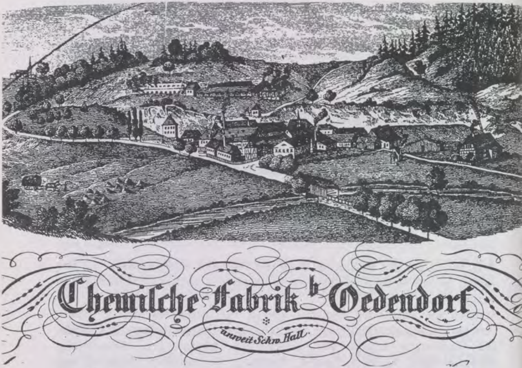
Abb. 10 Chemische Fabrik bei Oedendorf, um 1830 bis 1840, nach einem Firmenkopf dieser Firma.
