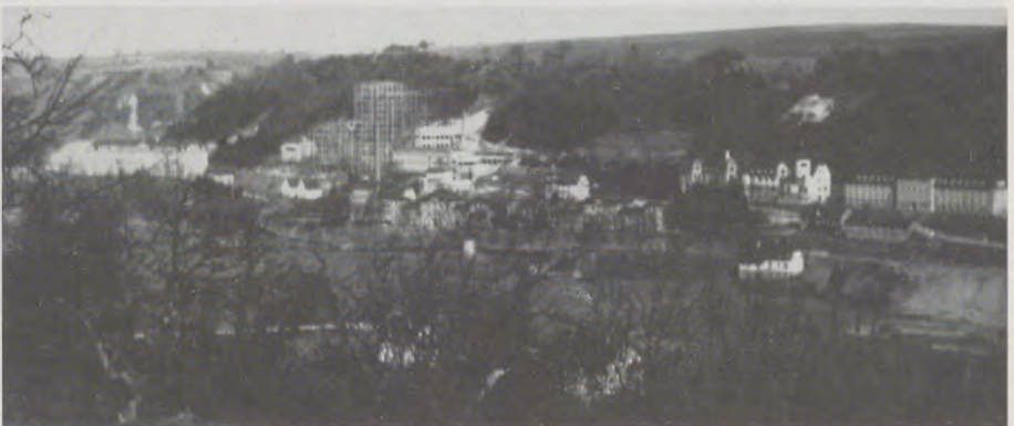
Abb. 38: Das eingerüstete Hochhaus im Bau
