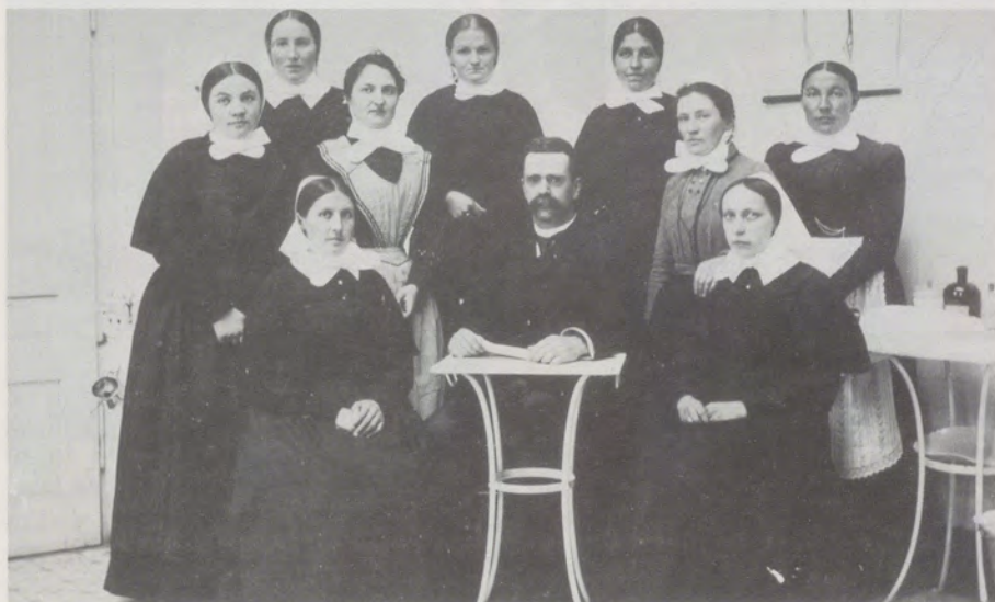
Abb. 27: Hausprüfung 1902 im alten Krankenhaus
