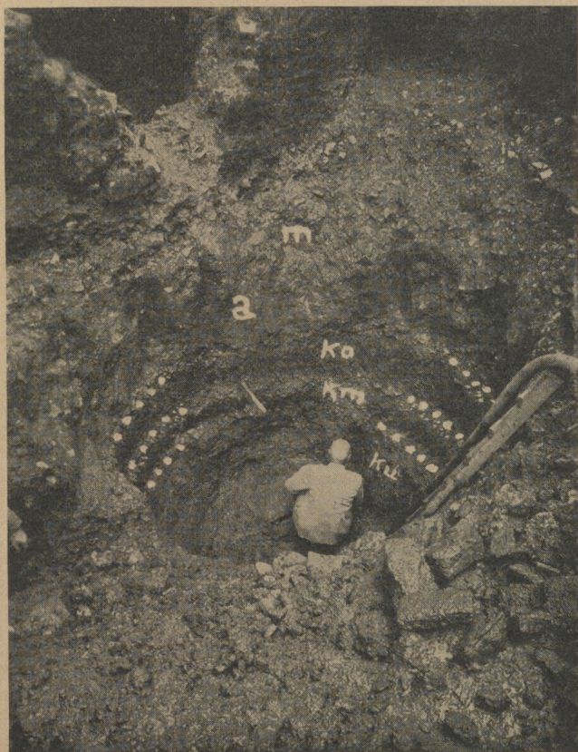
Abb. 28. Untersuchungsgrube im Baugrund der Landeszentralbank (Milchmarkt) Schwäbisch Hall bis zu 7 m Tiefe. m Mittelalterliche Schichten und Auffüllungen, darüber Keller, a Aulehm mit unterliegendem Einschwemmungsgeröll zwischen Mittelalter und Vorzeit, Ko obere Keltenschicht, Km mittlere Keltenschicht, Ku untere Keltenschicht. Dazwischen . . . . trennende Zwischenschichten von Überschwemmungsgeröll. — Der eingesteckte weiße Stab bezeichnet die Höhe des heutigen Grundwasserspiegels; die Grube ist zur Untersuchung ausgepumpt. (Aufnahme: W. Eichner)
