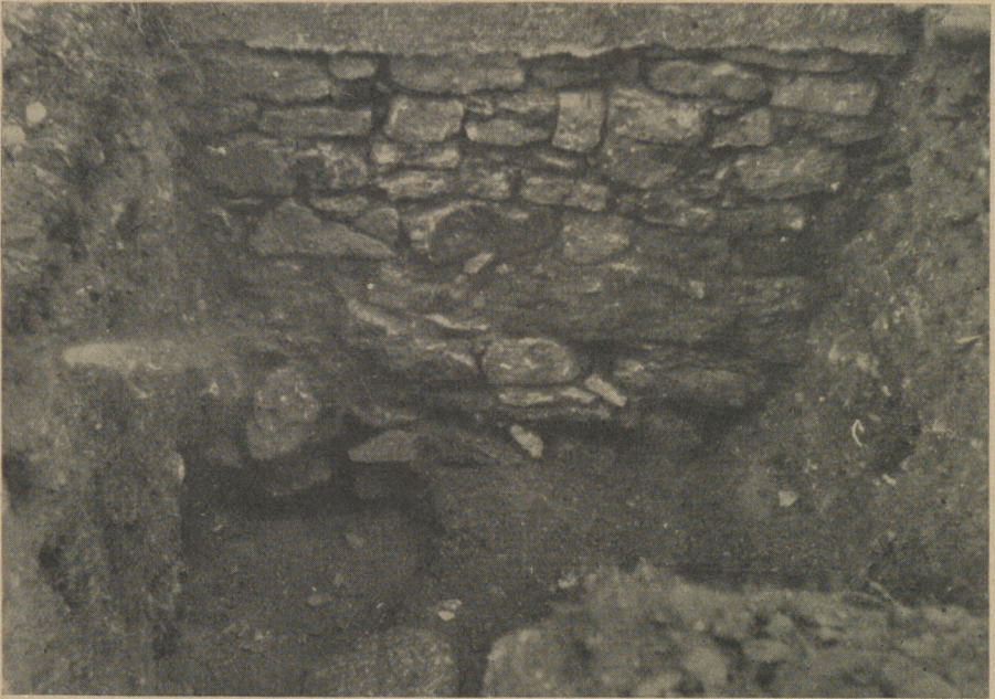
Abb. 27. Unterreggenbach, Pfarrkirche. Mauerverband der Nordseite.
