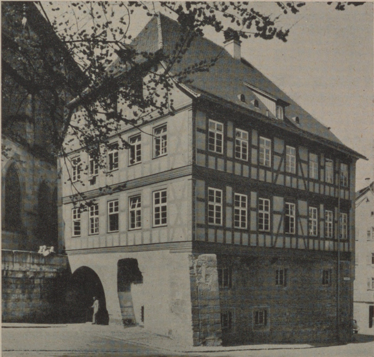
Abb. 4. Das alte Gymnasium zu Schwäbisch Hall.
