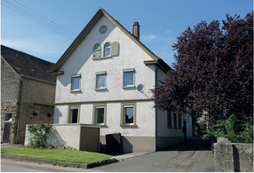
Ehemaliges Schulhaus in Freudenbach, erbaut 1834 (Foto: W. Brändle, 2017)
