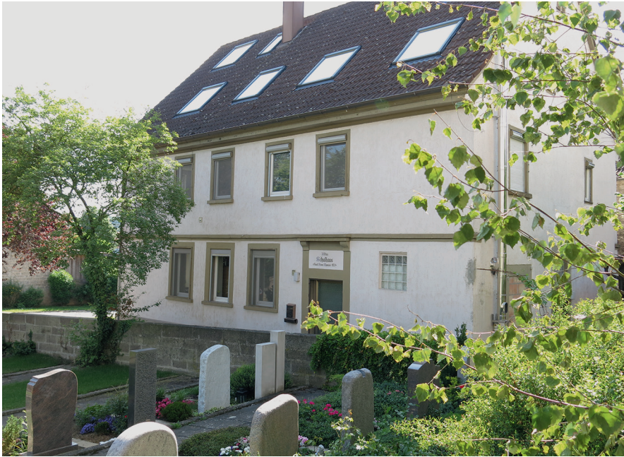
Ehemaliges Schulhaus in Freudenbach, erbaut 1834 (Foto: W. Brändle, 2017)
