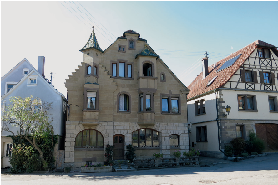
Häuserreihe in Freudenbach mit Haus Nr. 3 in der Mitte – ehemaliges Gasthaus ‚Goldener Stern‘, Neubau von 1912 nach Entwurf des Architekten Friedrich Vorherr (Foto W. Brändle, 2016)
