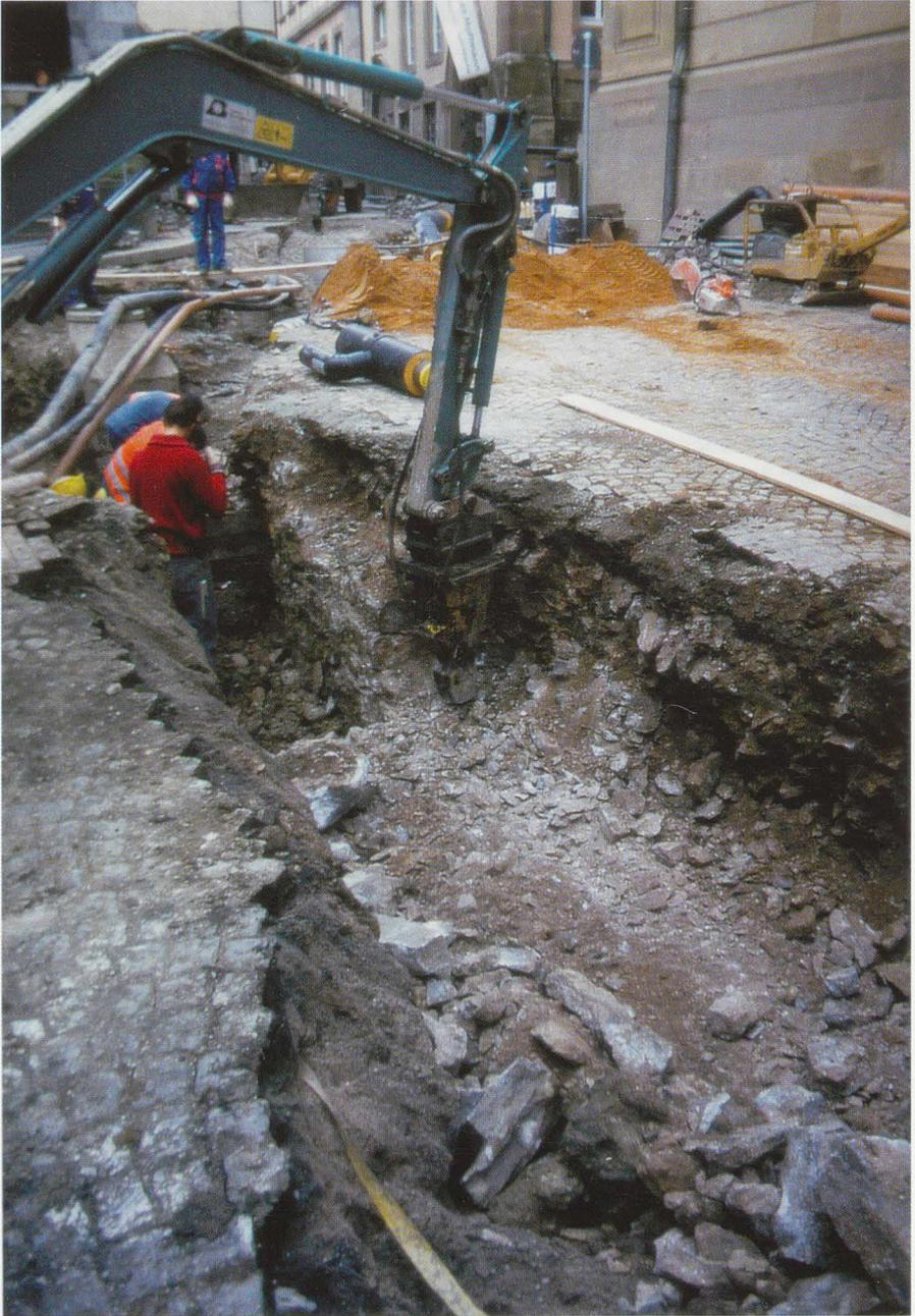
*Abb. 6 Verlegung der Fernwärmeleitung am Hafenmarkt 1998.
