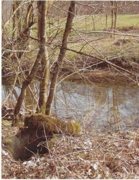
Abb. 11 Siphon (rechte Bachseite)
