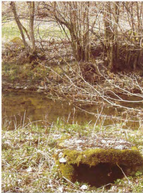
Abb. 12 Siphon (linke Bachseite)
