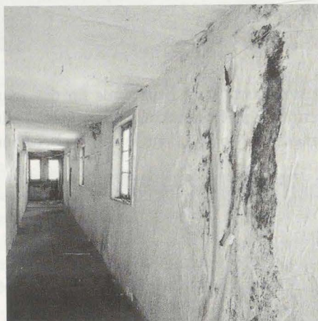
Abb. 12 Flur im Kutschenflügel, Aufnahme 1997. Die Feuchteschäden führten zu sichtbarer Zerstörung der Gefache und des Putzes (LDA, A. W.).
