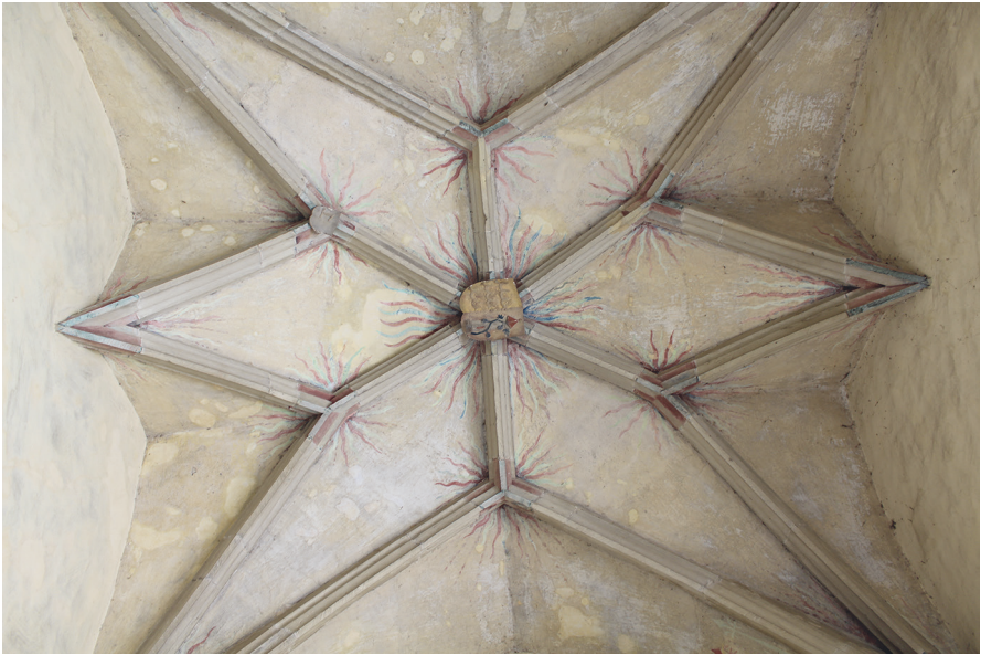
Abbildung 17: Gewölbe des Marbacher Kirchturmes.
