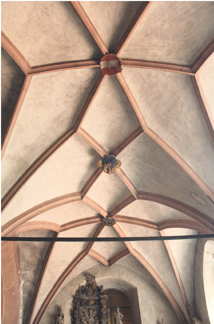
Abbildung 9: Blick in das Gewölbe der Dalberg-Kapelle in Herrnsheim.
