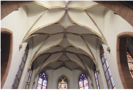
Abbildung 11: Blick in das Chorgewölbe der Pfarrkirche in St. Martin.
