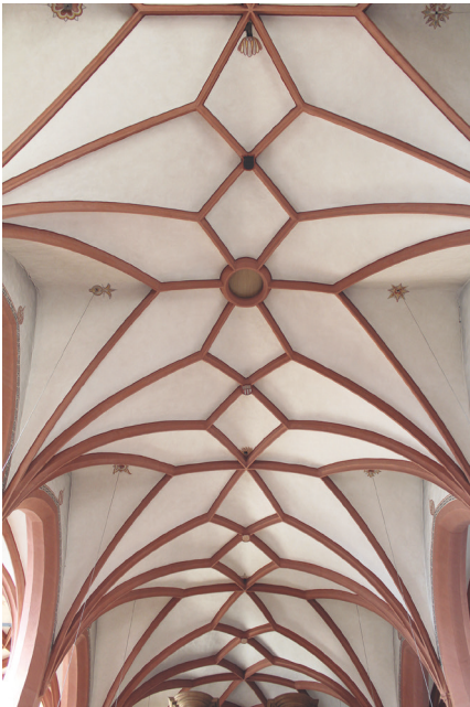
Abbildung 13: Blick in das Langhausgewölbe zu Bechtolsheim.
