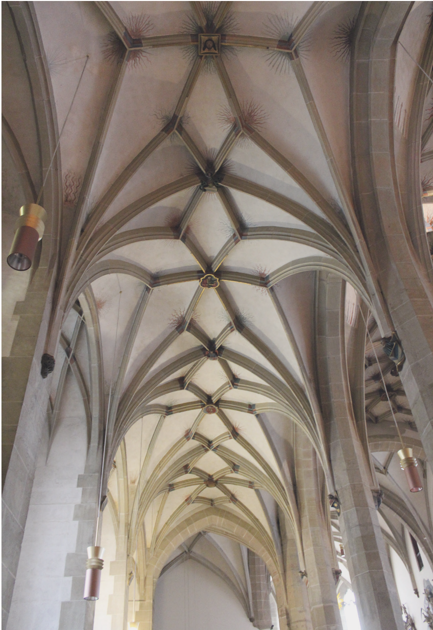
Abbildung 7: Blick in das Gewölbe des nördlichen Seitenschiffes in der Öhringer Stiftskirche.
