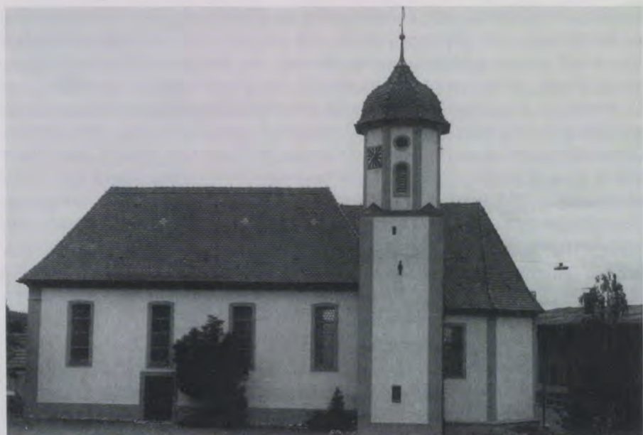
Abb. 1 Ansicht der Schwenninger Kapelle von Süden
