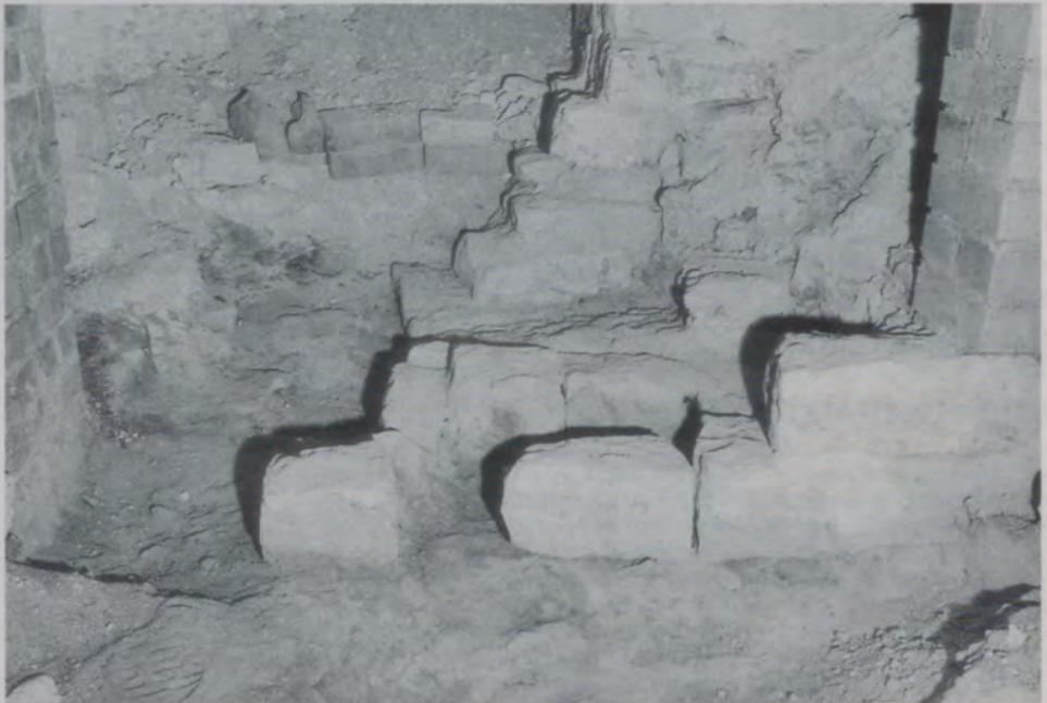
*Abb. 15 Kreuzgang. Blick in den nördlichen Zugang zur Kirche. Im Vordergrund Reste eines Stufenunterbaus, am oberen Bildrand die auf der Innenseite verputzte Südwand des Durchgangs. Links eine barocke, rechts eine moderne Backsteinmauer.*
