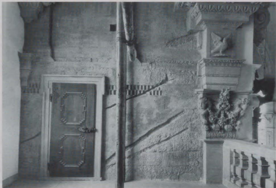
Abb. 13 Dachanschläge. An der Westwand des Nordturmes ist deutlich die unterschiedliche Neigung und Höhe des wiederholt veränderten Mittelschiffdaches ablesbar.
