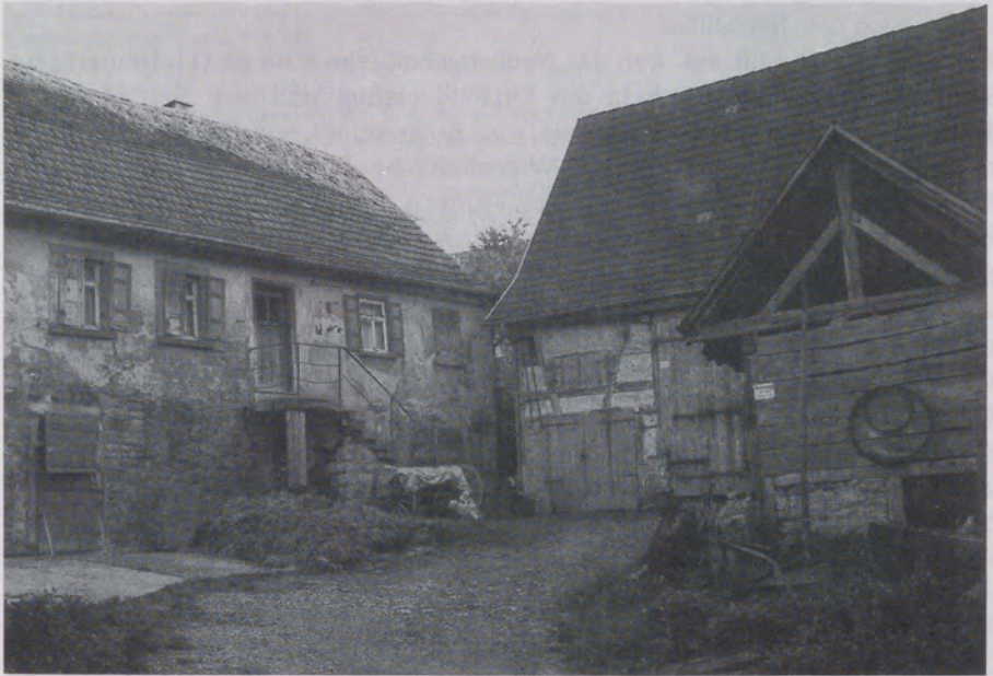
Abb. 2: Dreiseitgehöft in Altkrautheim. Das gestelzte Einhaus beherbergt im gemauerten Erdgeschoß zwei Ställe mit separaten Zugängen. Der Wohnteil im ersten Geschoß ist eine Fachwerkskonstruktion, die sich unter dem Verputz verbirgt. Die Scheune in der Mitte und das Wirtschaftsgebäude auf der rechten Seite stellen eine spätere Erweiterung des Gehöfts dar. Dieses Anwesen mit dem gestelzten Einhaus als Ausgangsform kann als typisches Bauerngehöft im Ginsbachtal bezeichnet werden.
