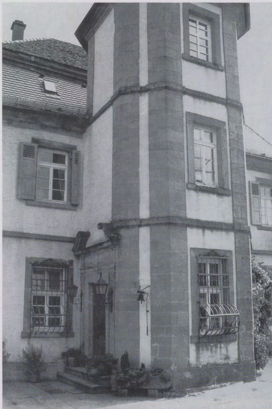
Abb. 7 Hauptgebäude des Buchhofs bei Sindringen
