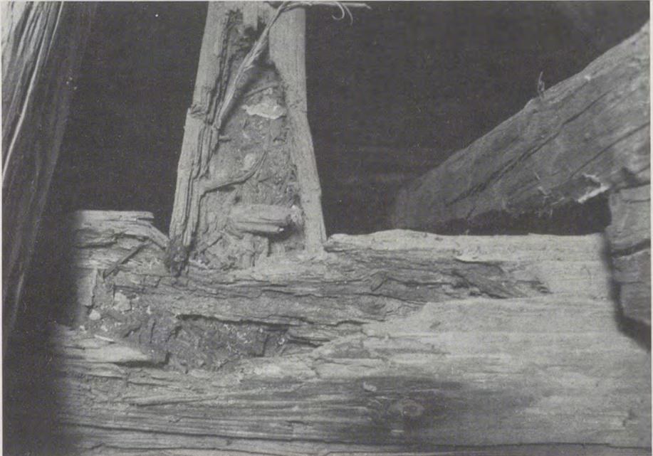
Zur Konstruktion der Dachstühle von Langhaus, Vierung und Chor ist zu sagen, daß alle drei nach dem gleichen Prinzip konstruiert sind. Es sind liegende Stühle mit einfachem Hängewerk, über Chor und Vierung dreistöckig, über Langhaus und Seitenschiffen vierstöckig, im Spitzboden ist jeweils noch ein Hahnenbalken eingezogen. Interessant ist, daß der alte Dachstuhl der Stuttgarter Stiftskirche nahezu identisch mit der Konstruktion in Öhringen war.
