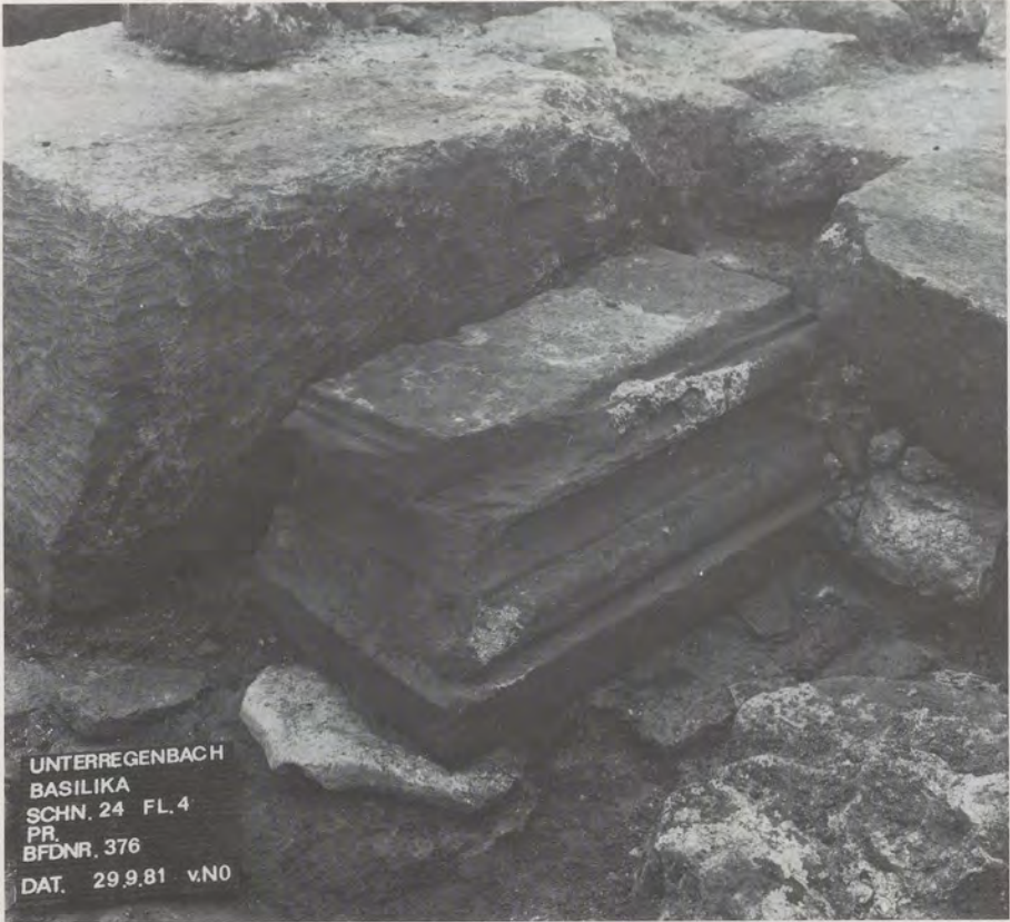
Abb. 9 Rest der attischen Pfeilerbasis Periode I im westlichen Pfeiler der Nordarkade Periode III, vgl. Abb. 8.
