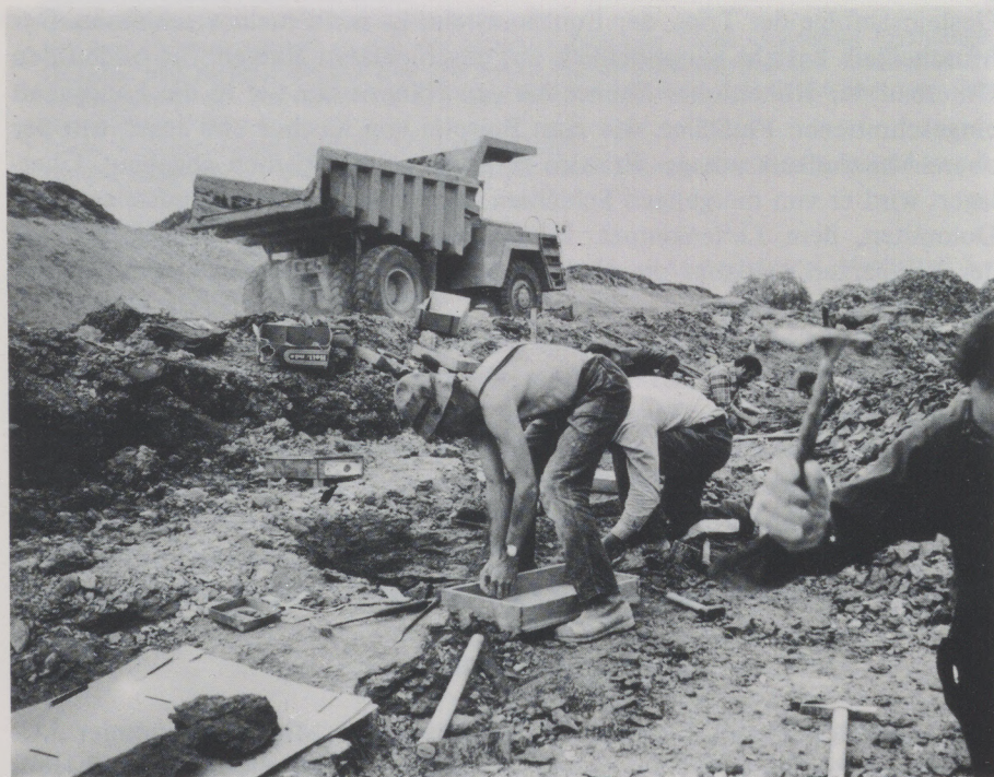
Grabungsarbeiten im oberen Lettenkeuper an der Autobahnneubautrasse bei Kupferzell-Bauersbach im Mai 1977.
