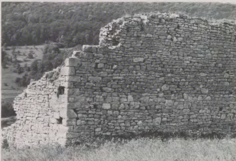
Abb. 5: Die „Zarge“, Mauerwerk der Nordostecke.
