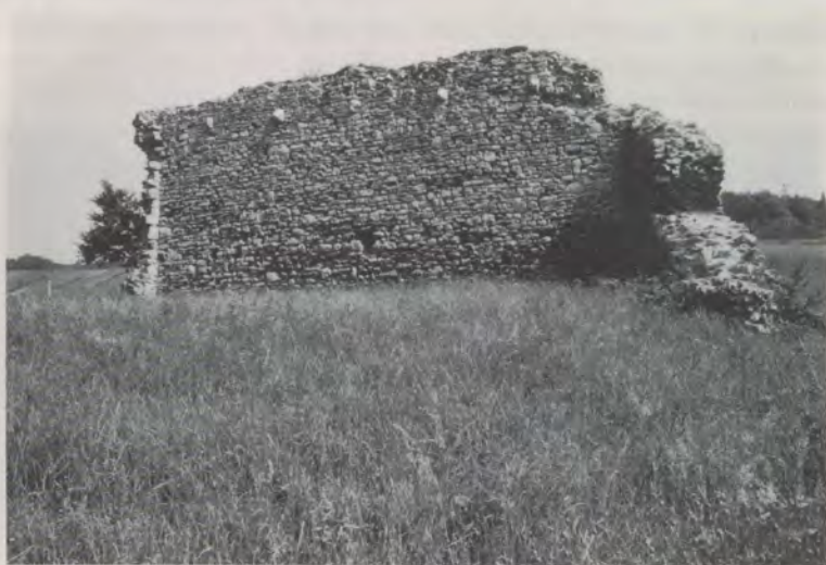
Abb. 4: Die „Zarge“, Ansicht von Süden (Innenseite).
