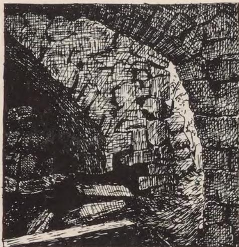
*Abb. 13: Stumpf, Vormauer und Ziegelausbesserung oben am Eingang*
