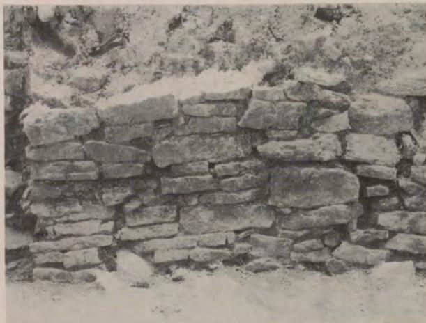
*Abb. 4 Mauersegment aus großen und kleinen Steinen*
