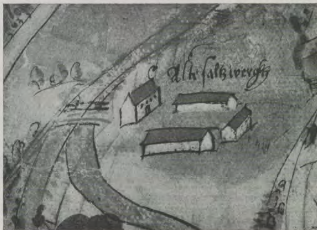
Abb. 4. Das alte Salzwerk des Hyronimus Karlin (1593—1604). Ausschnitt aus der älteren Hospin-Karte. Nachgetragen sind eine Laufverlegung des Kochers sowie die Steinbrücke von Criesbach und die Salinengebäude. Links bei der Brücke das Wohn- und Siedehaus; die langgestreckten Bauten sind Lepperwerke.
