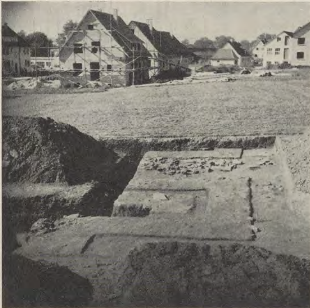
Abb. 5. Rendelkastell Öhringen. Fundamente der südlichen Tortürme in der 2. Bauperiode mit der zwischen beiden liegenden Stückung des Weges. Blick nach Westen.
