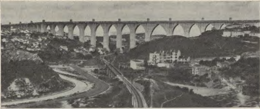
Aqüadukt „das Aguas Livres“ in Lissabon.
