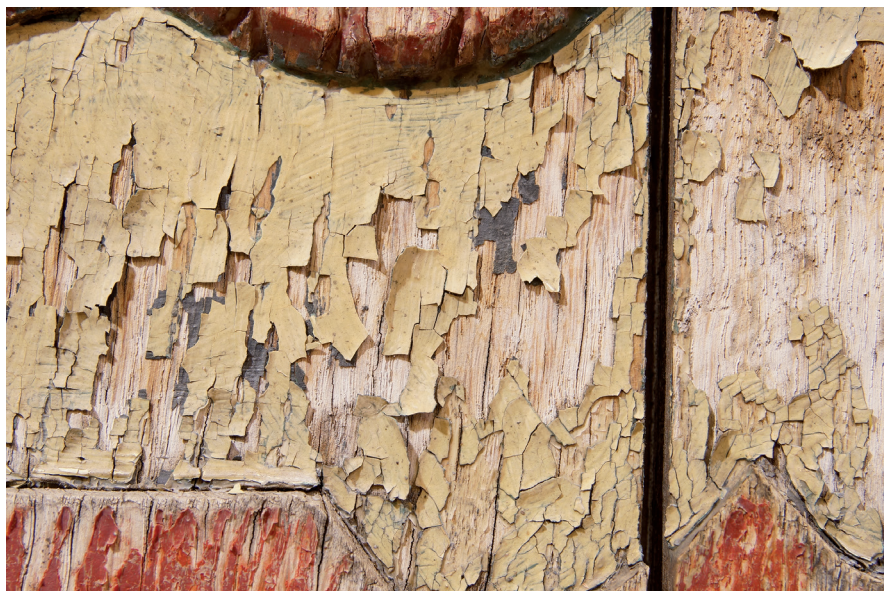
Abb. 2 Detailaufnahme der sich lösenden Farbschichten (Aufnahme: Volker Immel, Ilshofen)
