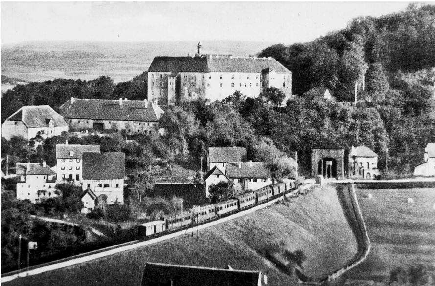
Kurz vor Niederstetten musste die Bahn unter dem Schloss Haltenbergstetten durchgeführt werden. Im Bild ist der Tunnel durch den Bergsporn und der Damm über das Tal zu sehen. Foto unbekannt, Sammlung Uwe Siedentop, ca. 1930.
