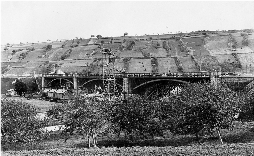
Die immer mehr steigenden Lasten, die die Bahn zu bewältigen hatte, verlangten immer stärkere Güterwagen. Um die verstärkten Achslasten transportieren zu können, mussten die Brücken aus der Anfangszeit in der Zeit nach dem Ersten Weltkrieg verstärkt werden. Im Bild zu sehen ist die Brücke bei Weikersheim während des Baues der heutigen Steinbrücke. Foto unbekannt, Sammlung Arbeitskreis Eisenbahnhistorie Württemberg.
