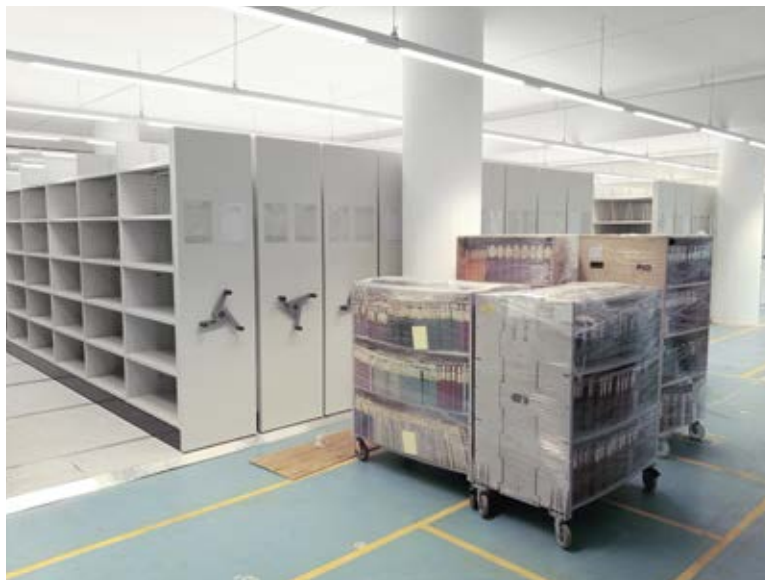
Regalanlage im neuen Magazin, © WLB Stuttgart
