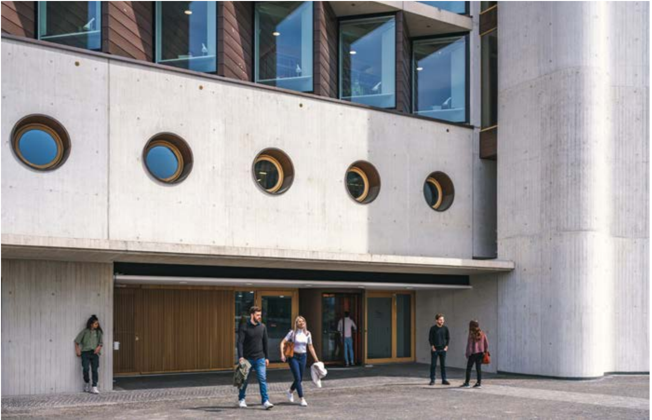
Haupteingang des Neubaus der WLB
