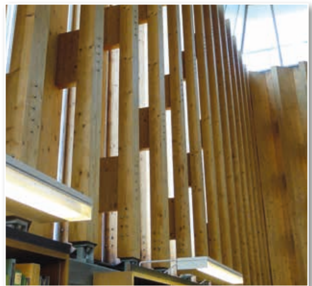
Abb. 5: Architektonische Details der Lesesaalfassade von innen
