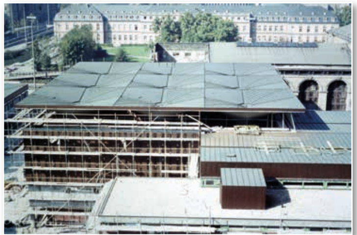
Abb. 2: Das neue Bibliotheksgebäude im Bau
