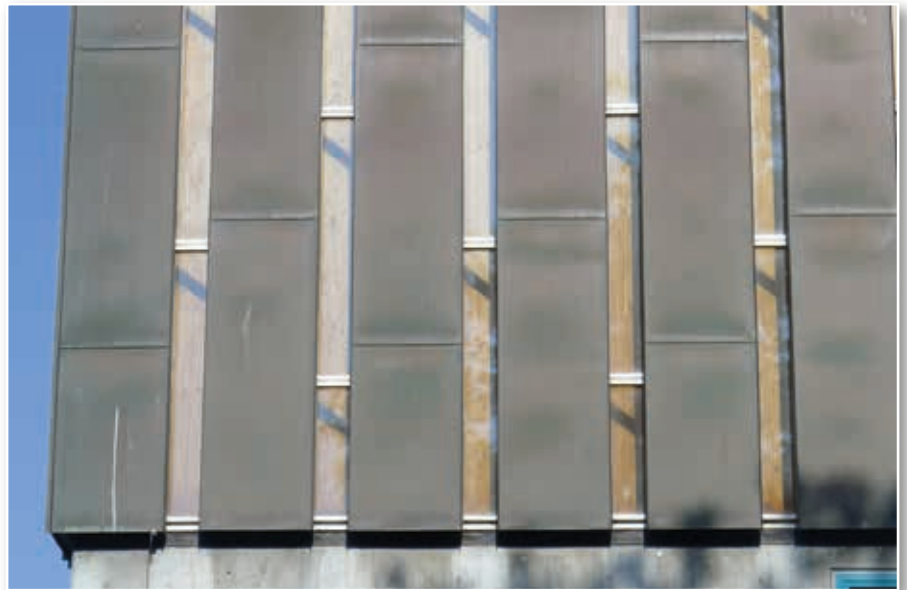
Abb. 4: Architektonische Details der Lesesaalfassade von außen
