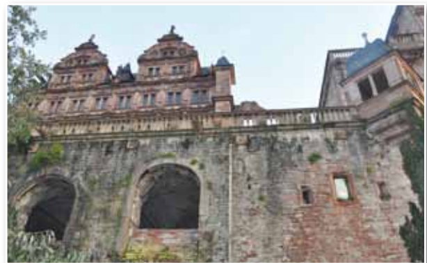
Abb. 8: Nordansicht des Altangebäudes, Foto: Julian Hanschke.
