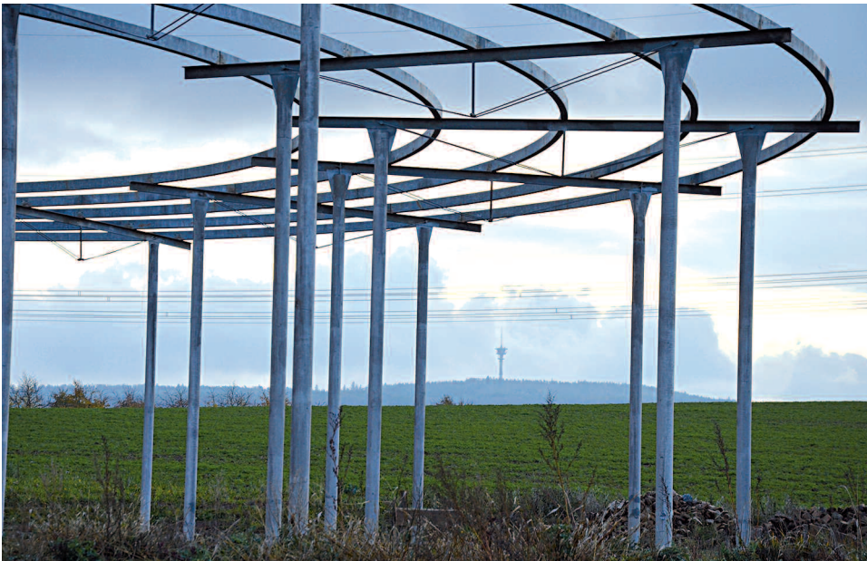
Im Herbst 2021 ist die Stahlkonstruktion am Mittelpunkt aufgestellt worden.
