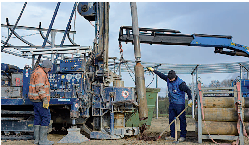
Im März 2022 wurde am Mittelpunkt ein Brunnen gebohrt.
