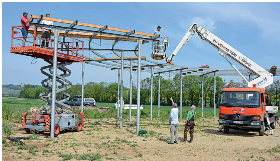
Das Dach der Loggia erhielt vom Hubsteigerwagen aus seine hölzernen Streben.
