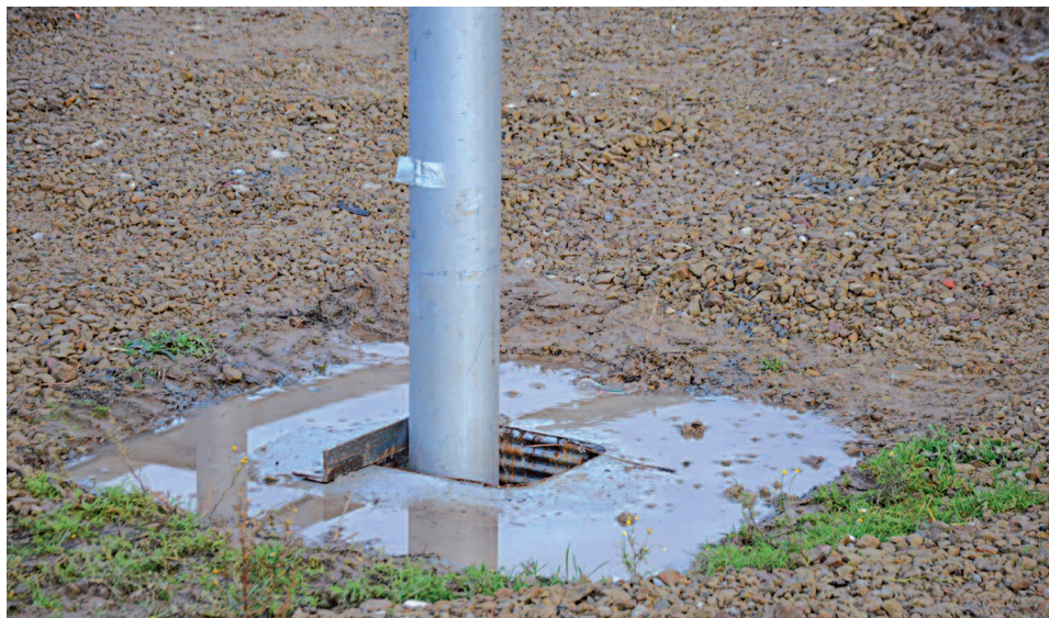
Jede Stahlstrebe hat ein eigenes Fundament, das mehrfach betoniert wurde.
