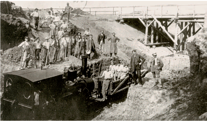
Euphorie herrschte im Sommer 1919 in Knittlingen nach erfolgtem „Durchstich“ der heutigen Wetterkreuzstraße in Richtung Großvillars. Doch mehr als diese Baufeldbahn sollte die Bahntrasse nie sehen. (Foto: Ausschnitt aus einer Mehrbildpostkarte; Vorlage: Wolfram Berner)
