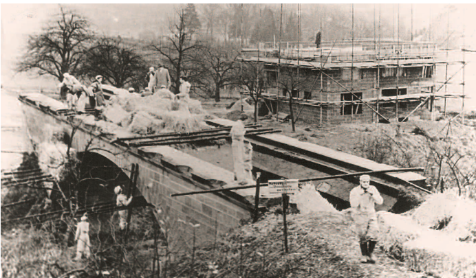
Ernüchterung 39 Jahre später. Am 15. Dezember 1958 erfolgte die Sprengung einer Bahnbrücke in Knittlingen, die nie von einem regulären Zug benutzt wurde. (Foto: Hans Hofmann, Sammlung: Siegfried Strobel)
