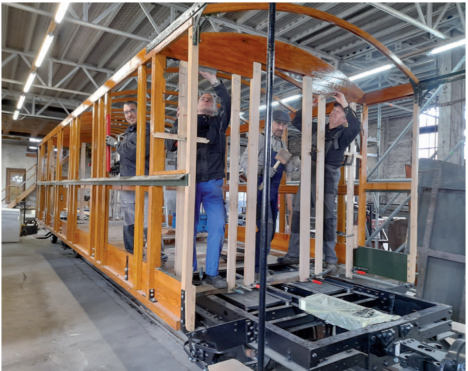
Am 9. April 2022 ist ein Teil der Werkstattmannschaft des Vereins Öchsle Schmalspurbahn im denkmalgeschützten Lokschuppen in Ochsenhausen mit dem Einpassen der Stirnwände des „Panoramawagens“ Stuttgart 132, der jahrelang im Zabergäu beheimatet war, beschäftigt. (Foto: Bernhard Günzl)
